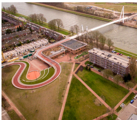
Cykelbro integreret i (over) skole i Utrecht.
